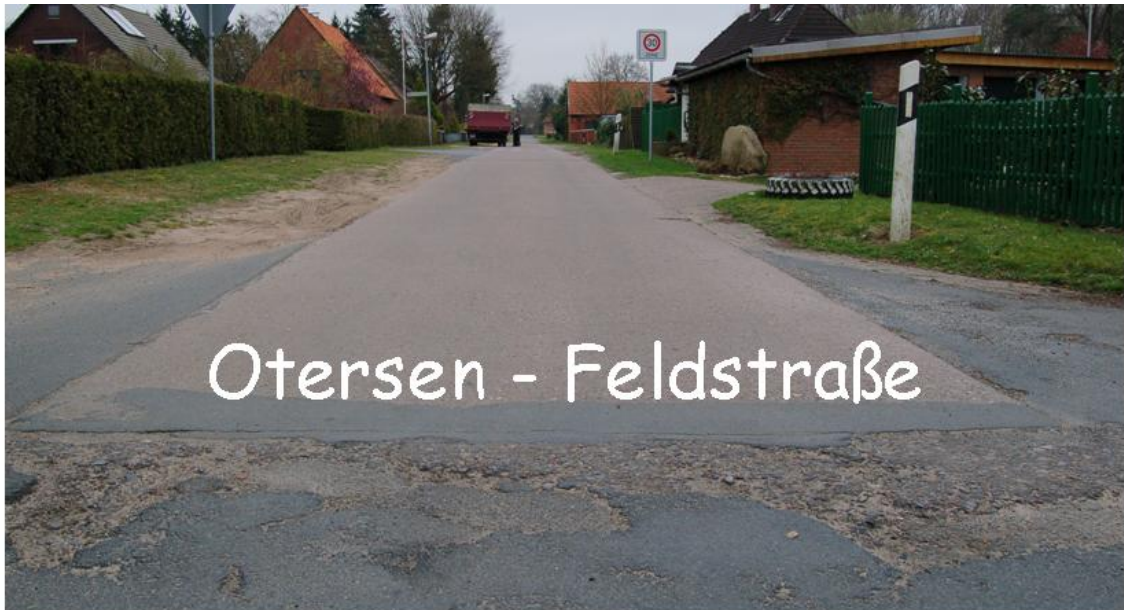
Risse - gebrochene Beton-Platten - Absackungen - ausgefahrene Seitenstreifen
